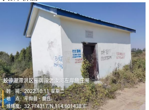
老汝河左岸詹庄闸
