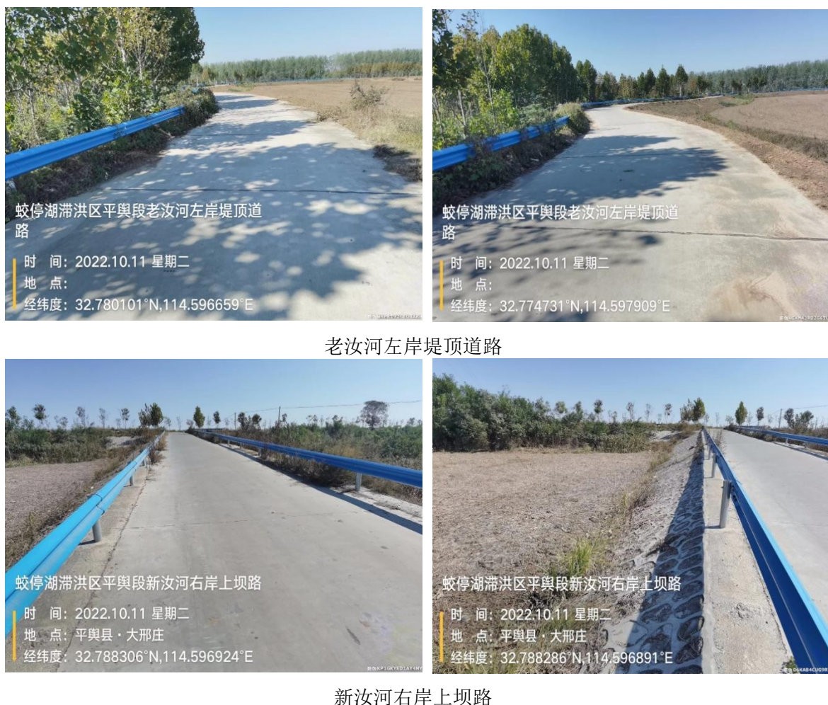
图 2.1-1 项目典型工程照片
