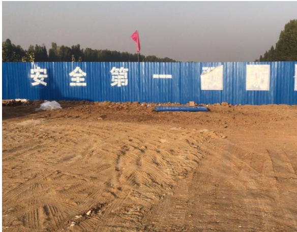
施工现场围挡
