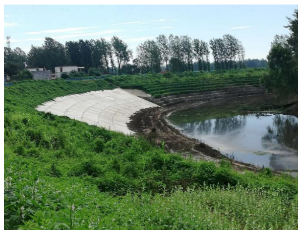
老鲁河宾格护坡（2018 年工程）
