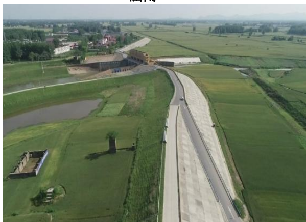
大坝及上堤防道路
