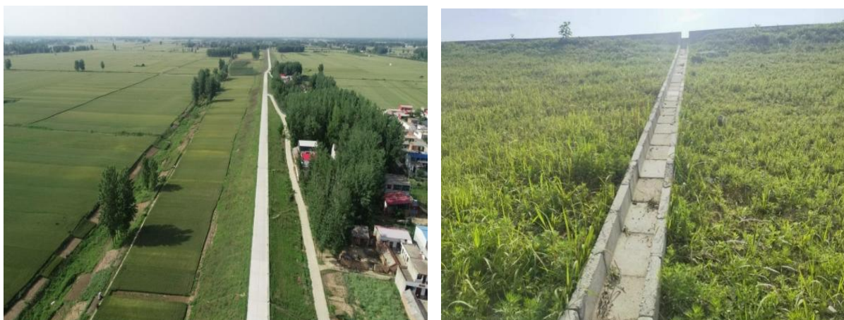
大坝及堤顶道路
