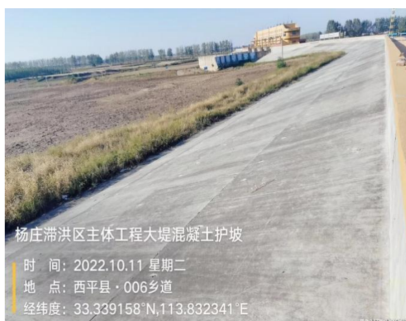
大坝坝体及坡面
